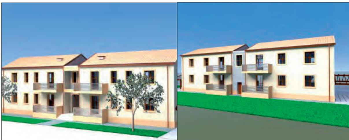
Un nuovo fabbricato a Licciana Nardi in Loc. Ponte Nuovo. Sono in corso di realizzazione quattro nuove unità abitative con una superficie di quasi 90mq ciascuno. L'edificio sarà realizzato con blocchi in cemento con isolante, che consentono una rapida costruzione ed estrema sicurezza dal punto di vista sismico.
